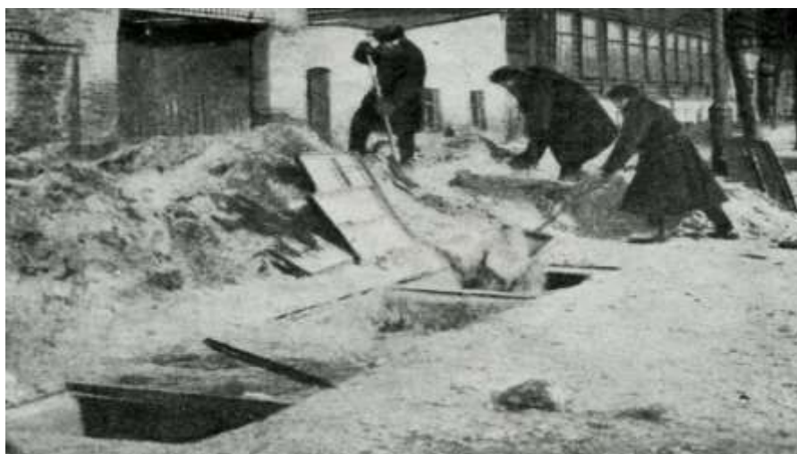
Стационарная снеготаялка инженера Д.В.Домашнева при банях на Библиотечной улице – люки для загрузки снега
