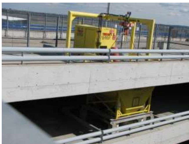
Стационарная снеготаялка Trecan 20-SG производительностью 20 тонн снега в час, установленная на крыше гаражной стоянки, Ниагара, Канада
