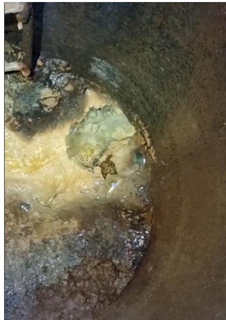
Общая длина прочищаемой трубы – 20 м. Диаметр – 400 мм. По длине минеральные отложения были распределены неравномерно: ближе к верхнему колодцу было закрыто 100% трубы, далее, в сторону течения стоков, слой уменьшался и на выходе в нижний колодец составлял менее половины трубы.
